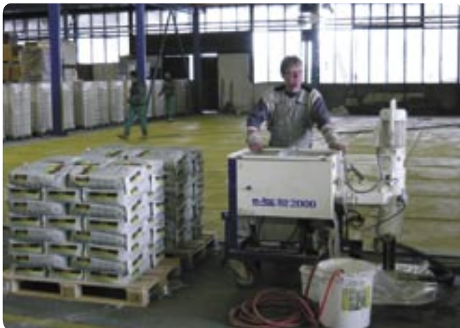
Čerpání objektové stěrky OSP 31 pomocí čerpadla v rámci servisu pro zákazníky.
