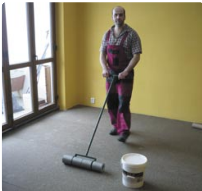
Nalepením izolační podložky DU 903 před lepením parket docílíme zlepšení kročejového komfortu a utlumení hluku o více než 21 dB.
