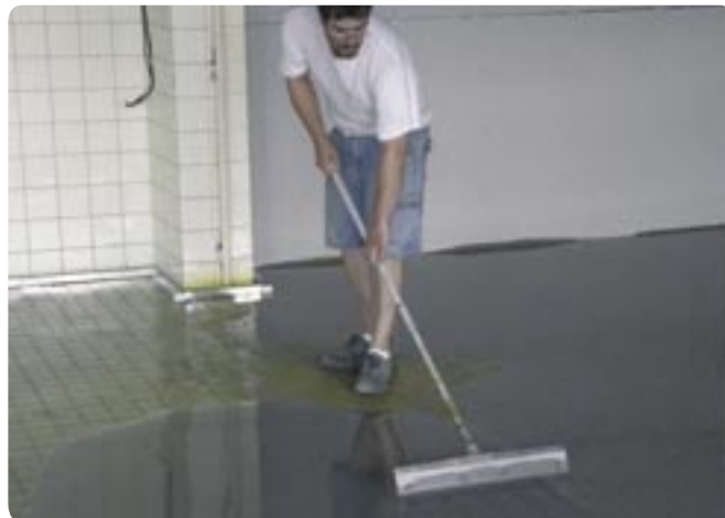
Zpracování rychlostěrky SSP 33 s rozlivem až 35 minut pomocí rakle.
