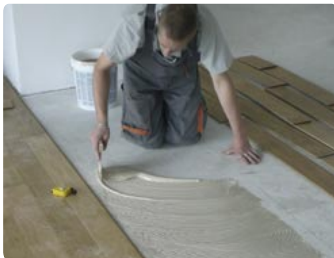
Lepení dubových masivních podlah na anhydrit pomocí MS lepidla na parkety PAR 365.
