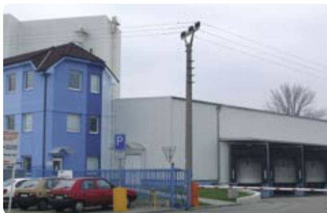
Pohled na nakládací rampy skladu a logistiky, zákaznický servis
