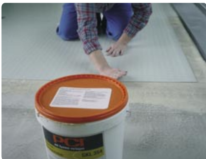
Lepení gumových čtverců pomocí lepidla na gumové krytiny GKL 354.
