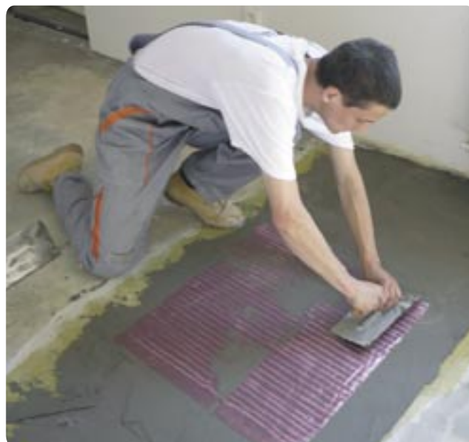
Sešítí prasklin v podkladu pomocí sešívací vložky GFS nahrazuje sešívání pomocí epoxidové pryskyřice.
