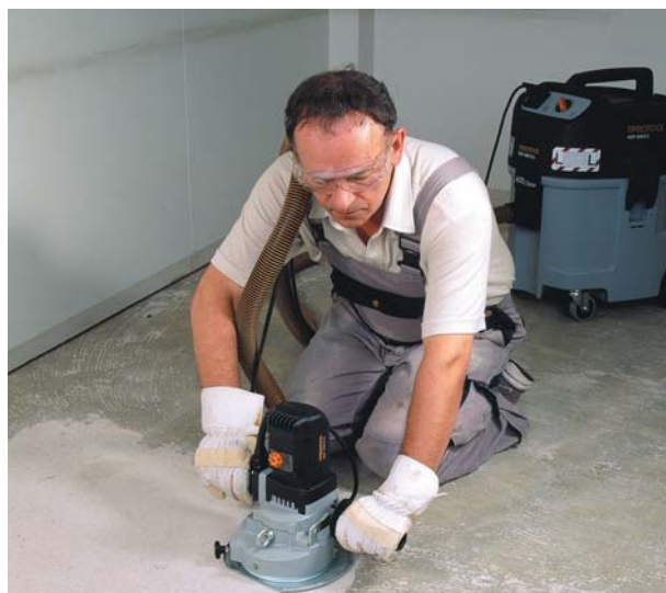
Ukázka vhodné úpravy starého podkladu za pomoci sanační frézky RGP 150-15 E
