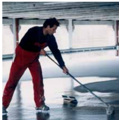
Aplikace penetrační vrstvy a posypu křemenným pískem
