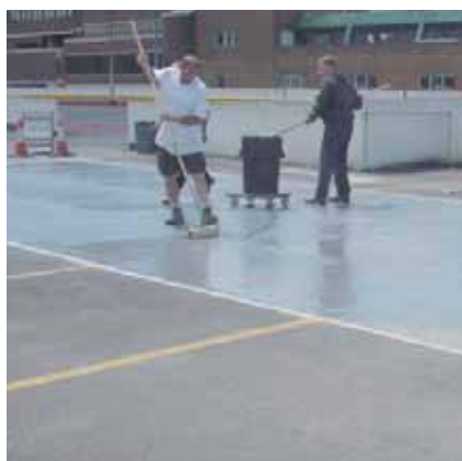
Aplikace uzavíracího nátěru
