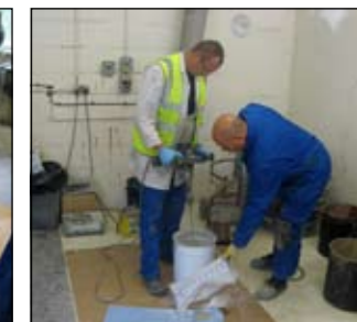
Míchání UCRETE® DP TOPCOAT
