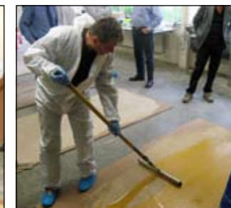
Aplikace penetrace UCRETE® PRIMER SC
