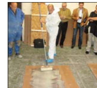
Nanášení penetrace UCRETE® PRIMER SC
