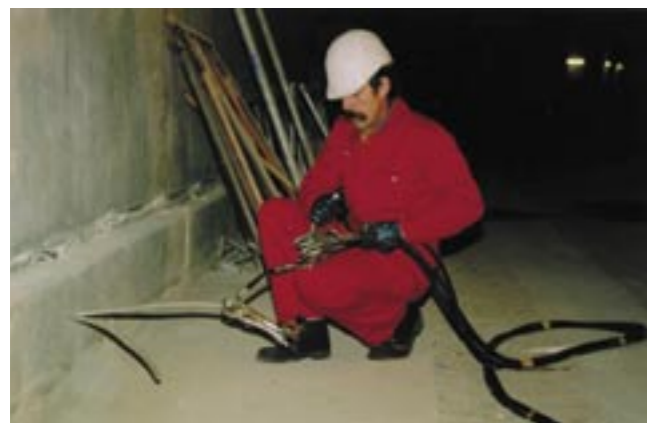
Injektáž hadičky Masterflex® 900 akrylovým gelem Masterflex® 801.
