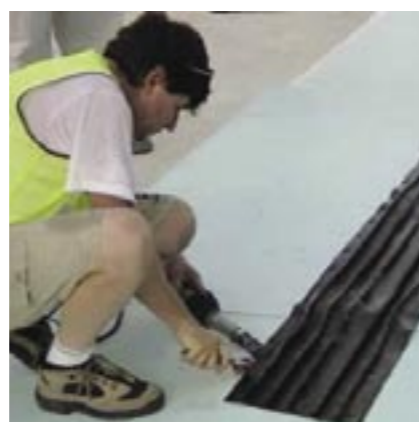
Příprava PVC pásů Masterflex® 2000 pro pokládku
