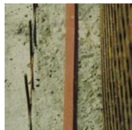
Pracovní spára s bobtnajícím páskem Masterflex® 610
