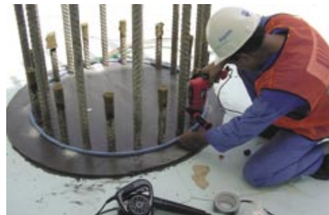
Montáž systému Masterflex® 900.
