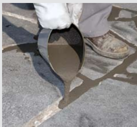
Spárování odpovídající barvou u rovnoměrně širokých spár
