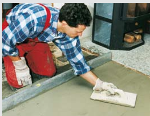
Vyrovnání podkladu opravnými maltami
