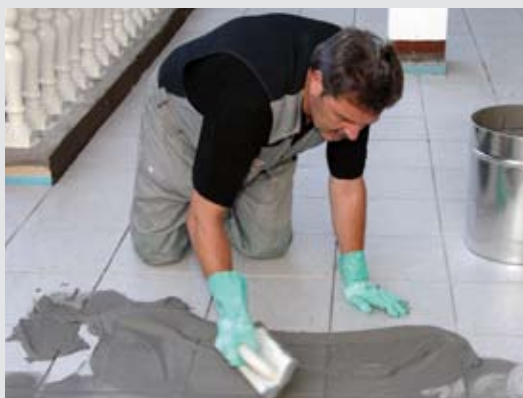
Spárování odpovídající barvou u rovnoměrně širokých spár
