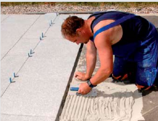
Lepení kamenů s tloušťkovou tolerancí do středně vrstvého lože
