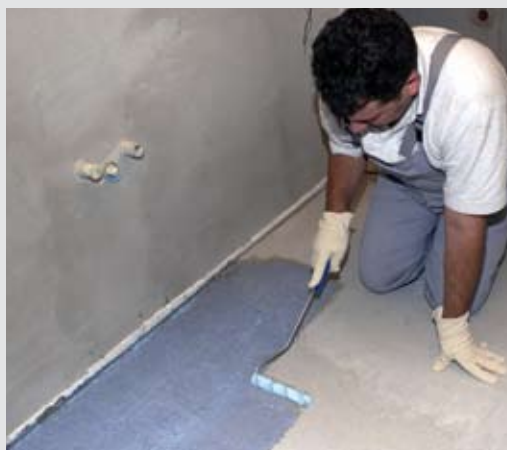
Penetrace PCI Gisogrund®
