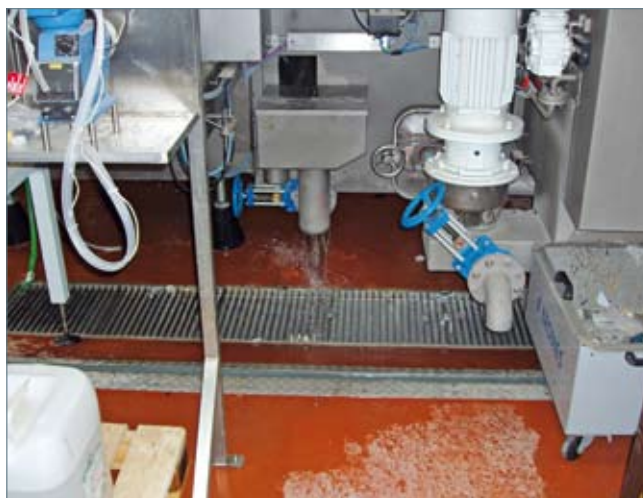
Staropramen Praha – průběh objektové dilatace před odvodňovacím kanálem
