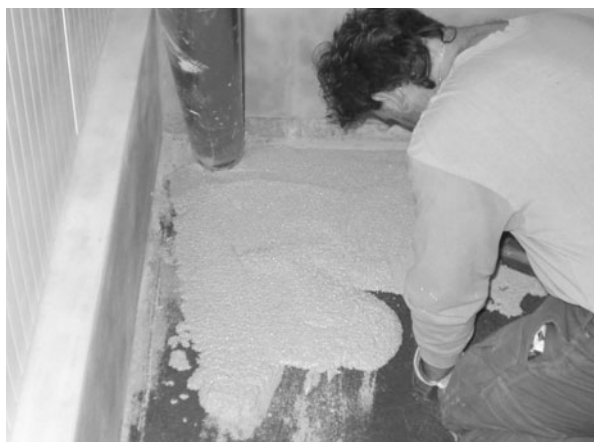
Aplikace podlahového systému UCRETE® UD200.
