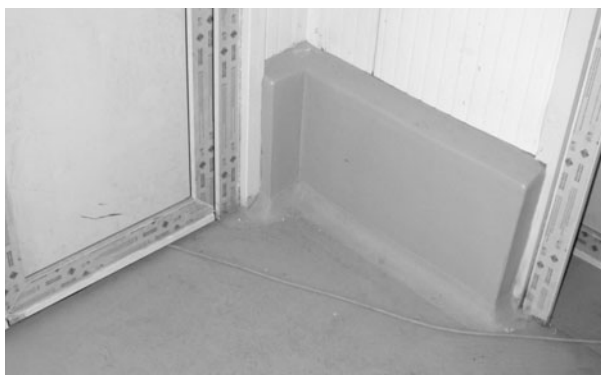
Fabion u termoizolačního panelu, který je chráněn betonovou zídou.
