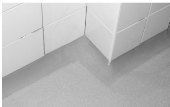
Fabion u stěny s keramickým obkladem.
