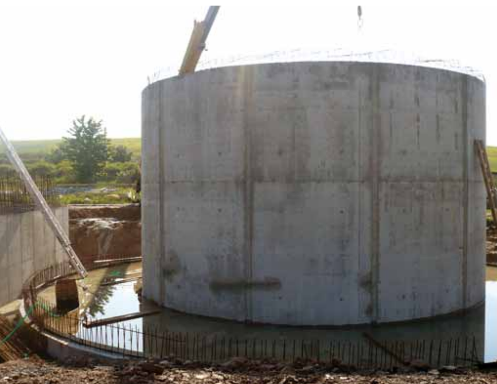
Z výstavby nádrže
