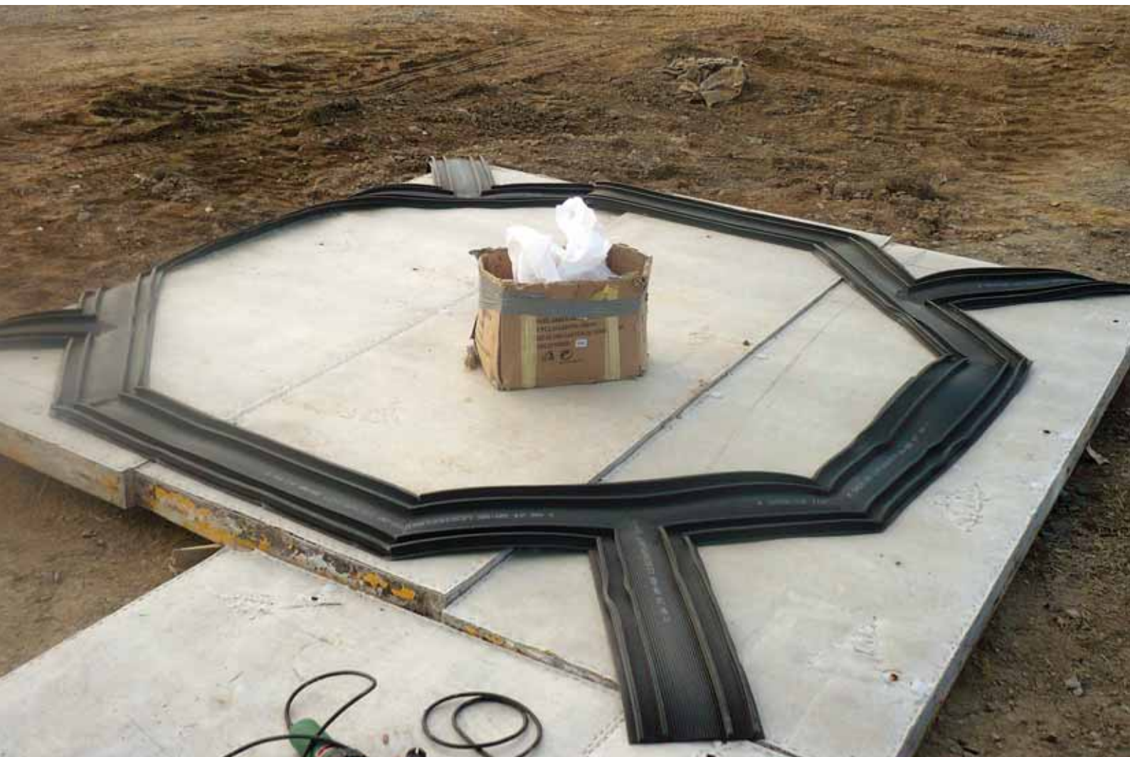
Výstavba: příprava těsnících prvků Masterflex 200 před betonáží
