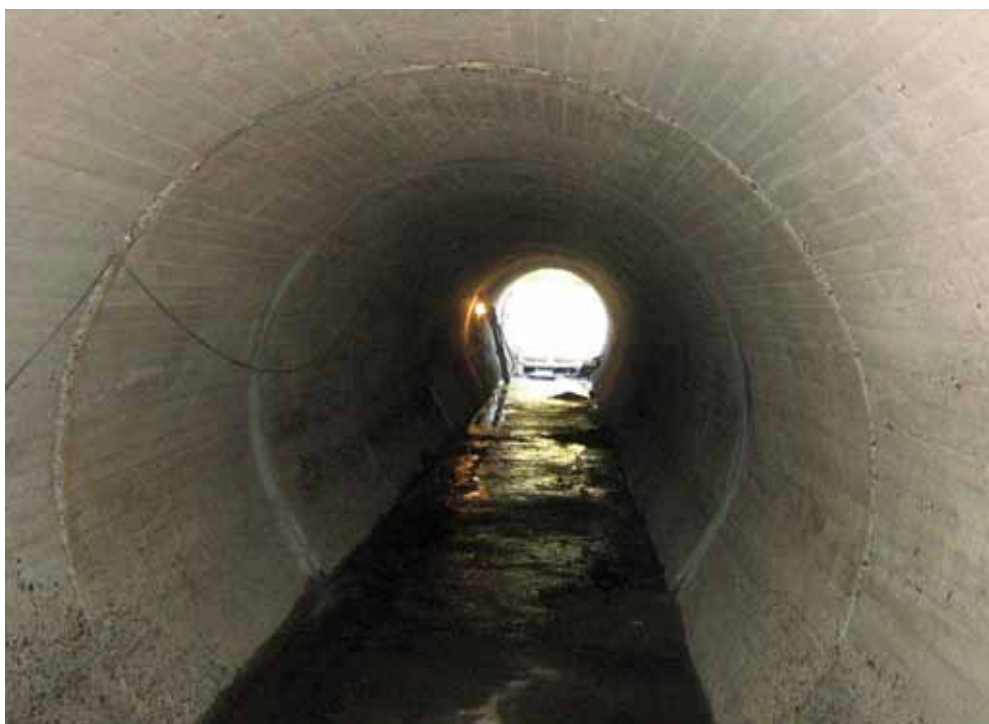
Sanace: suchý objekt po sanaci
