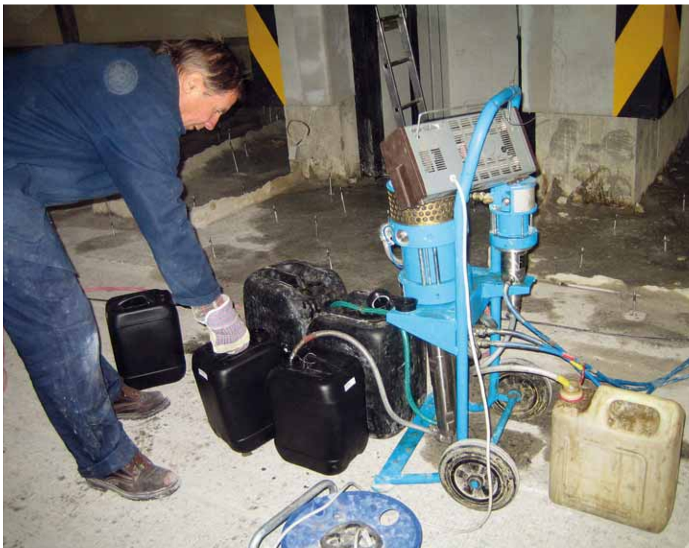
Sanace: při injektáži – obsluha tlakového čerpadla
