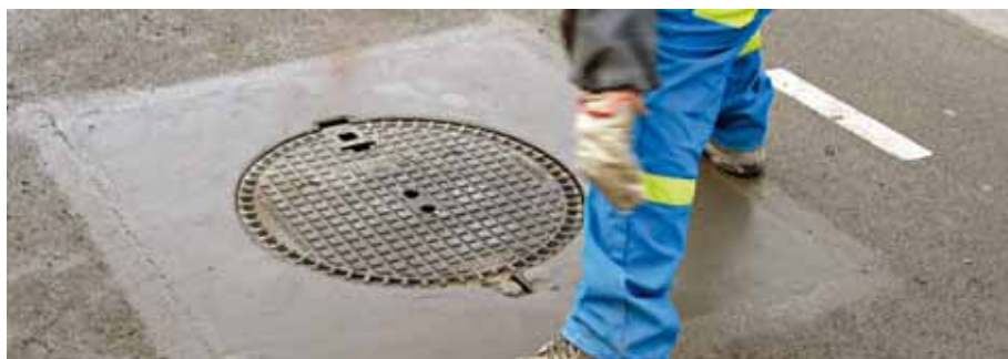
Emaco Fast Tixo – po 2 hodinách lze obnovit provoz
