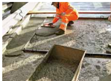
Emaco Fast Fibre – bleskurychlá oprava betonové desky
