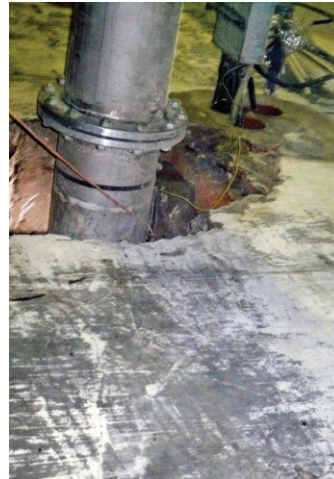
Prostup potrubí stěnou objektu před aplikací bobtnajících pásků a pasty
