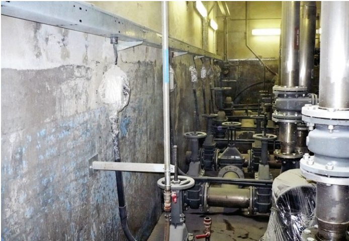
Ukázka připraveného podkladu stěny objektu pro sanační práce
