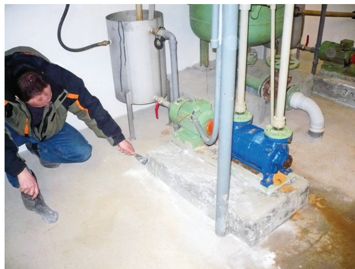
Úprava betonové základové patky pod čerpadlem v průběhu sanace strojovny vodojemu
