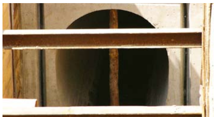
Těsnění svislé pracovní spáry bobtnavým profilem MASTERFLEX® 610
