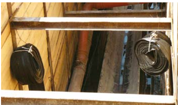
Průběžné námoty těsnícího pásu
