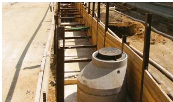
Celkové náhledy na výstavbu stoky
