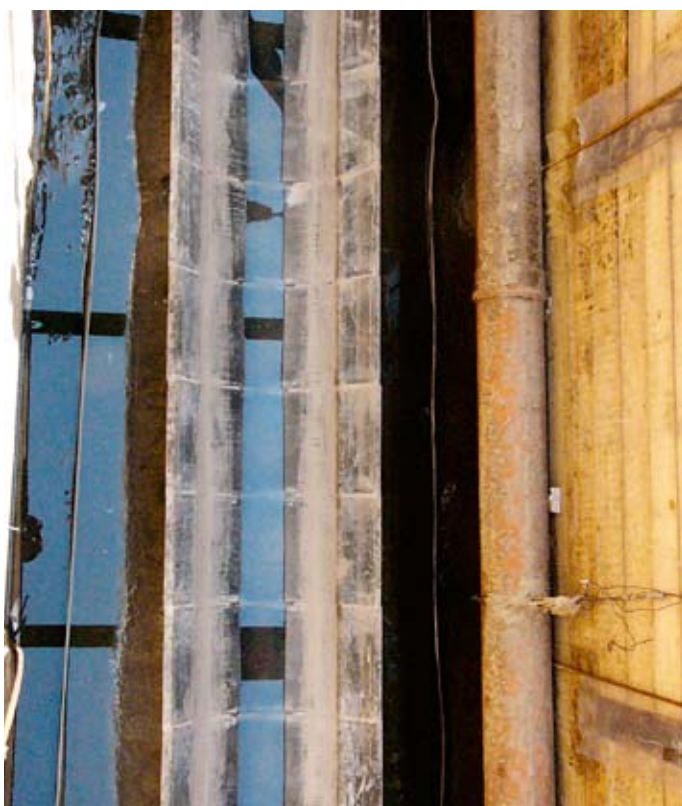
Čedičové tvarovky tvořící dno budoucí stoky, podélně s nimi jsou patrné pásy MASTERFLEX®
