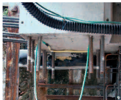
Způsob uchycení injektážních hadiček
