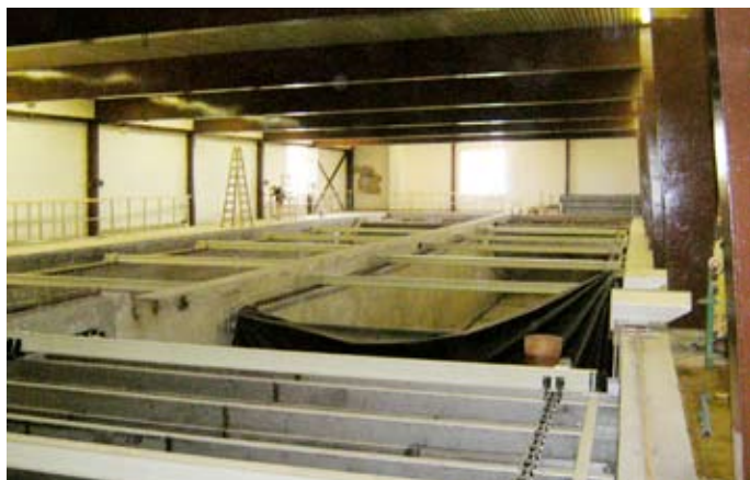
Sanované plochy před aplikací finální stěrky PCI Dichtschrämme
