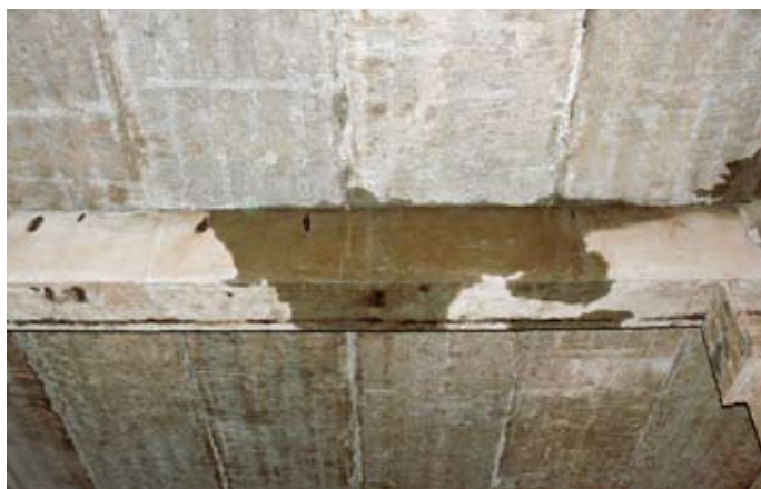
Průvlak v objektu vodojemu před sanací
