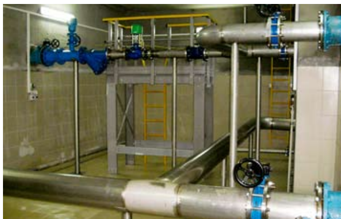
Technická místnost s armaturami po provedení sanačních prací
