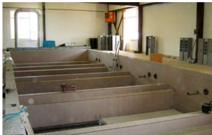
Lapáky písku – obklady s použitím lepidla a spárovací hmoty PCI s atestem na pitnou vodu
