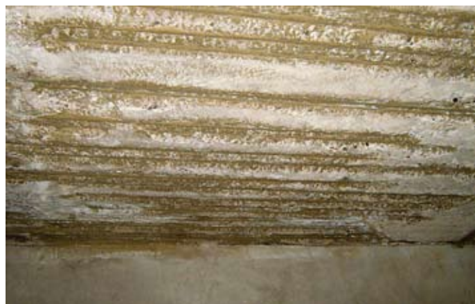
Ošetření prvků výztuže antikoročním nátěrem na minerální bázi EMACO® NanoCrete AP
