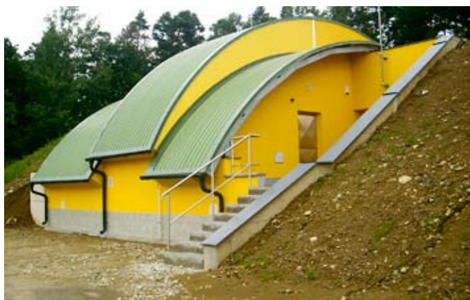
Vodojem Borovina po celkové rekonstrukci
