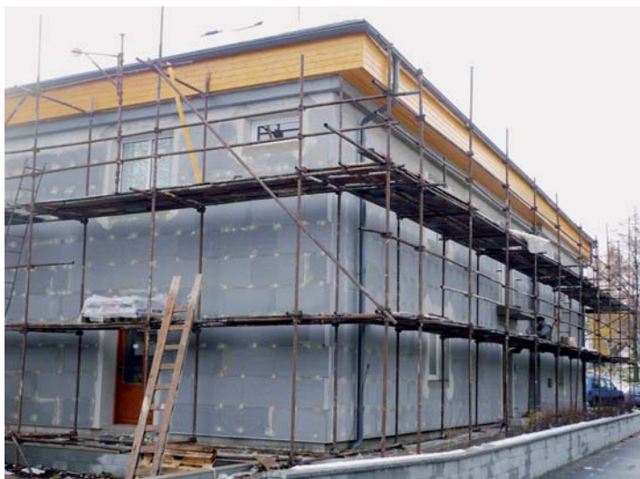
MultiTherm® NEO - průběh zateplení administrativní budovy v Litomyšli, podzim 2007.
