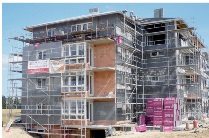
Nejnovější realizace systému MultiTherm® NEO - zateplení budoucnosti, Žďár nad Sázavou, srpen 2008.
