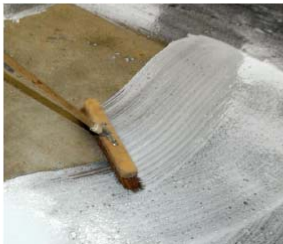
PCI ZemTec Pri rozetřít rovnoměrně s kokosovým koštětem nebo plochým štětcem na vyčištěný a předpřipravený podklad.
