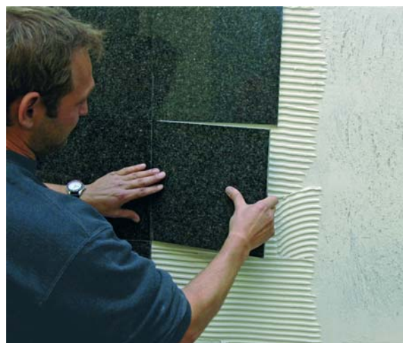
Pokládání obkladu z přírodních opracovaných obkladů na stěnu s materiálem PCI Carralight®.
