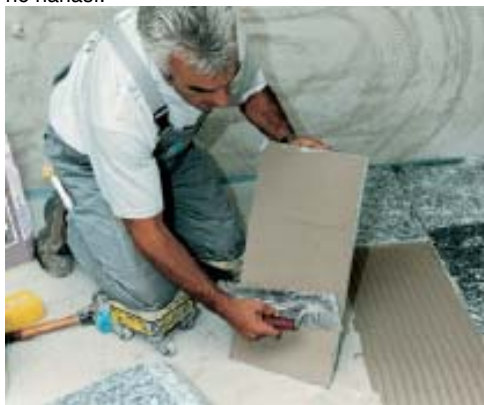
Aby se při pokládce zamezilo tvorbě dutin, nanáší se lepidlo i na rubovou stranu dlažeb i obkladů.
