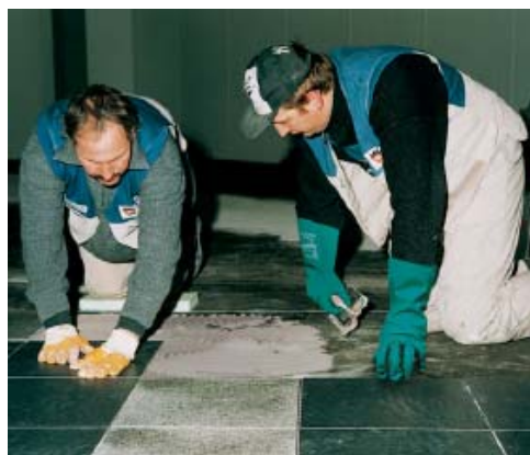
Dlažbu z přírodního kamene lze spolehlivě položit metodou středně silného lože s maltou PCI Carrament®.
