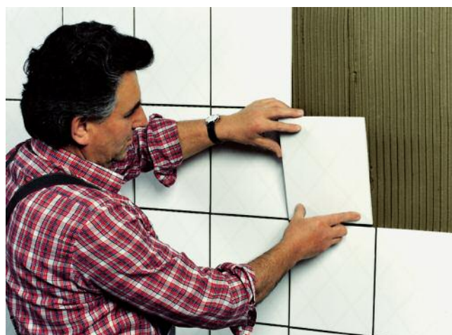
Funktionssichere Plattenverlegung im Dünnbettverfahren mit PCI FT-Klebemörtel.
