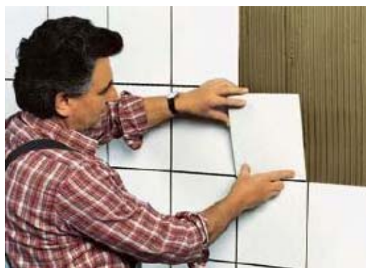
Kvalitní tenkovrstvé lepení obkladaček pomocí PCI FT-Klebemörtel.
