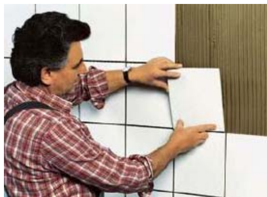
Kvalitní tenkovrstvé lepení obkladaček pomocí PCI FT-Klebmörtel.
