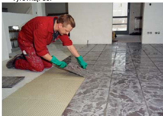
Pokládání dlažby do lepidla PCI Everflex
