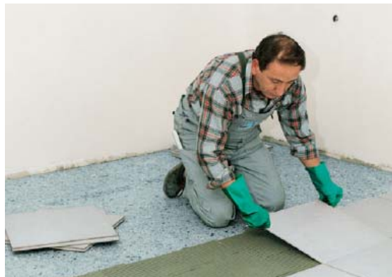
Pokládání keramické dlažby do lepidla PCI Everflex na PCI Polysilent.
