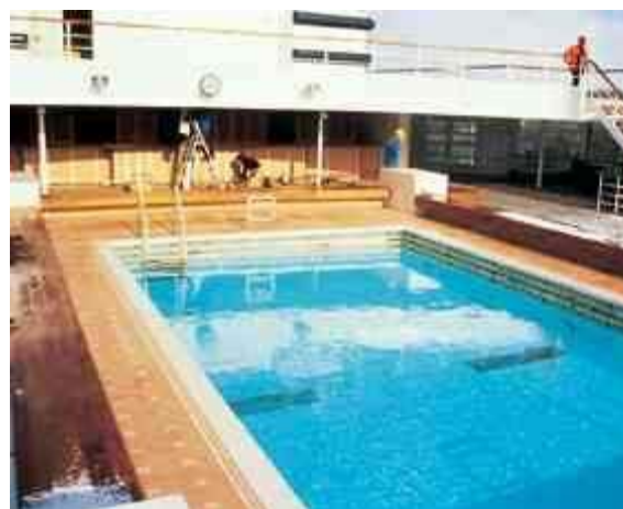
Dlažba a obklady položené v bazénu s PCI Collastic®.
