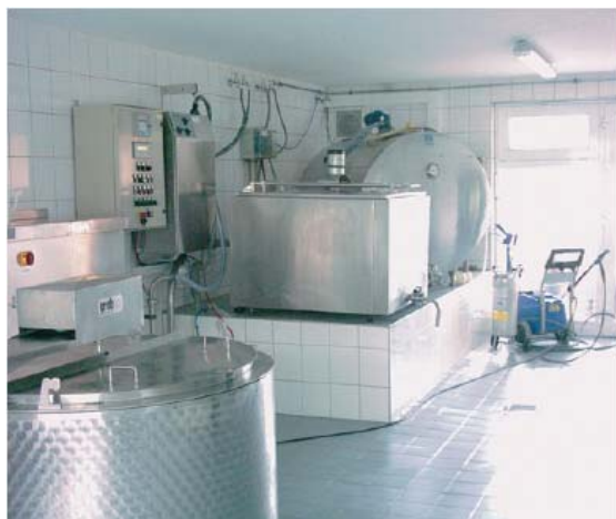
Obklady a spárování vysoce odolné proti opotřebení a chemickému zatížení např. v mlékárnách.
