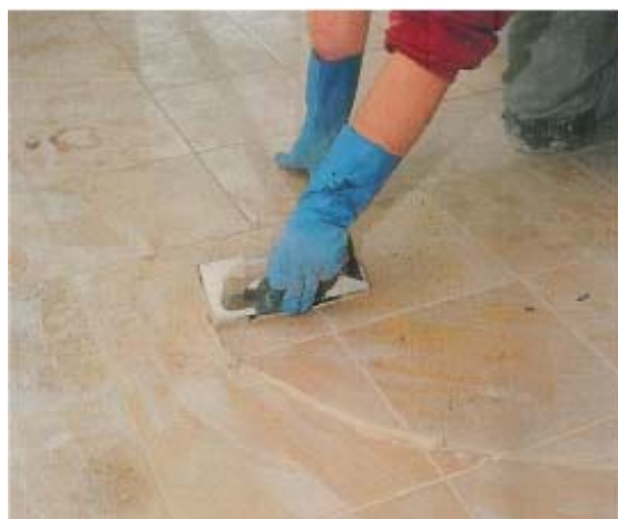
Spárování mramoru a desek z přírodního kamene hmotou PCI Carrafug®.
