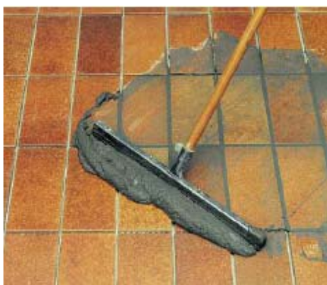
Spárovací hmota PCI FT -Fugenbreit se vpraví do spár. Povrch se stáhne....
