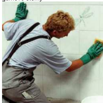
Ulpěné zbytky cementového šlemu odstraníme vlhkou houbou.
