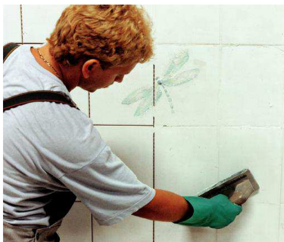
Se spárovací maltou PCI FT-Fugenweiss lze bez tvorby trhlinek zatahovat spáry šířky od 2 do 8 mm
