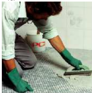
PCI spárovací maltu vpravujeme intenzivně do spár pomocí gumové stěrky
