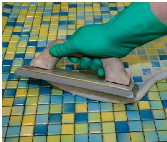
S materiály PCI Durapox NT a PCI Durapox NT plus je vyspárování mozaiky chemicky odolné a vodonepropustné.
