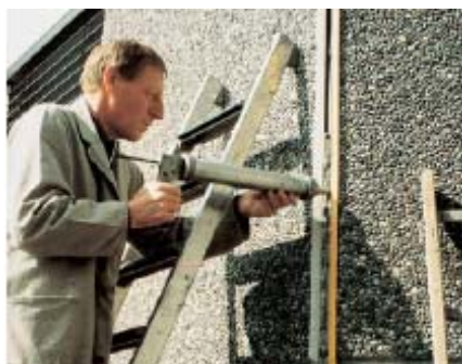
Těsnění dilatačních spár tmelem PCI Elritan® 100 na fasádě z vymývateľného betonu.
