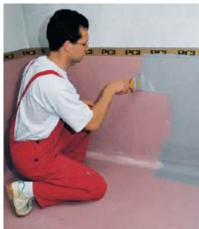
Pro dokonalou izolaci proti průsakům olejí je zapotřebí provést minimálně penetraci a dva krycí nátěry. Po cca 8 hodinách schnutí se nanese druhý nátěr PCI Visconal ® šedý.
