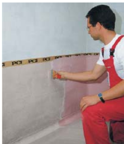
Na penetraci PCI Visconal naředěný 50% vody lze po cca 8 hodinách schnutí nanést první ochranný nátěr neředěným PCI Visconal červený
