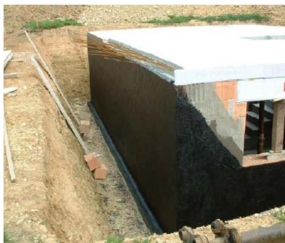
Izolace vnější stěny sklepa z betonu s PCI Pecimor ® 2K. Plnění polystyrénovými částicemi zvláčňuje a vede ke snadnému zpracování.
