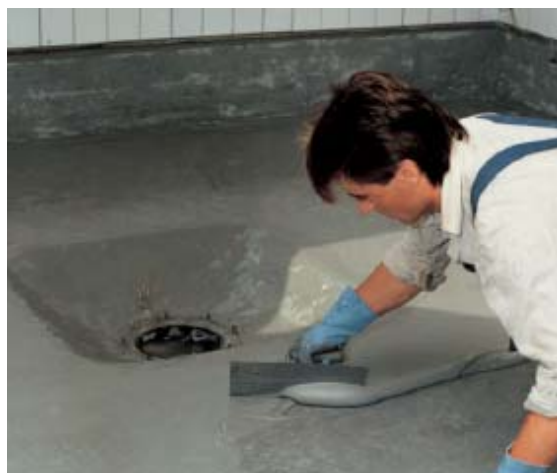
Nanášení PCI Apoflex TF Boden pod keramický obklad velkokuchyně
