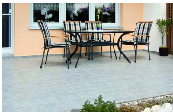
Pokládka keramiky na izolační a překlenovací podložku PCI Pecilastic® U je velmi jednoduchá a bezpečná.
