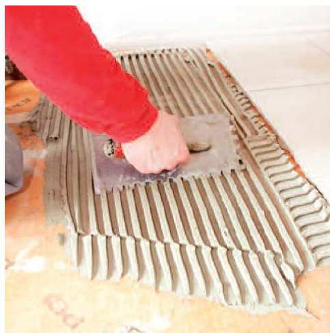
4. a následně se pokládá keramická dlažba na PCI Nanoflott®, nebo PCI Rapidflott®.
