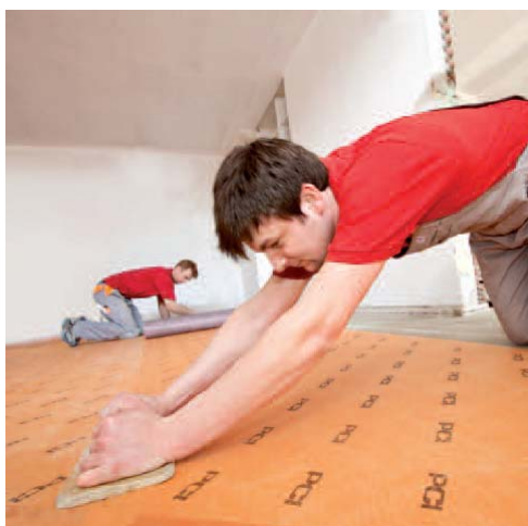
2. PCI Pecilastic® U se při pokládce řádně přitlačí k podkladu pomocí dřevěného prkna, nebo desky z tvrzené gumy.
