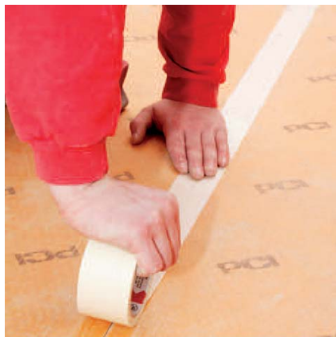
3. V suchých prostorech se jednotlivé spoje slepí lepicí páskou, v prostorech zatížených vlhkostí se izolují pomocí PCI Pecitape® 120...
