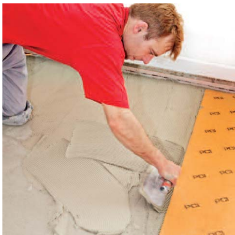
1. Nanášení PCI Nanoflott® light, nebo PCI Rapidflott® na připravený podklad.
