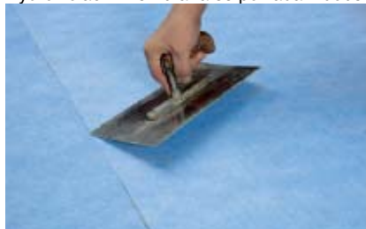
Membrána se přitlačí lžící, pryžovým válečkem nebo latí.
