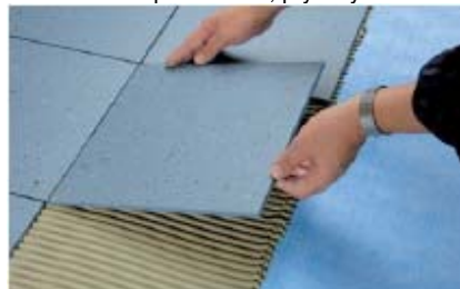
Po vytvrdnutí tenké vrstvy lepidla je možné pokládat dlažbu z keramiky nebo z přírodního kamene přímo na membránu PCI Pecilastic W.
