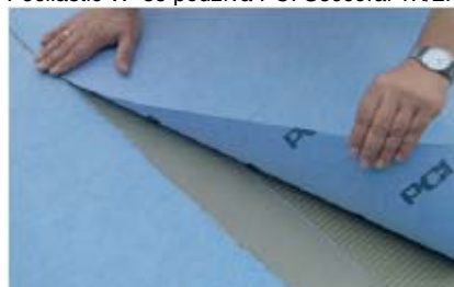
Hydroizolační membrána se pokládá v době lepidlosti.
