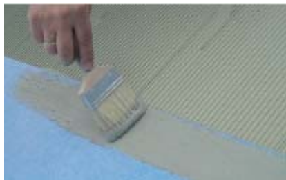
Pro bezpórovité přetření spojů hydroizolační membrány PCI Pecilastic W se používá PCI Seccoral 1K/2K.
