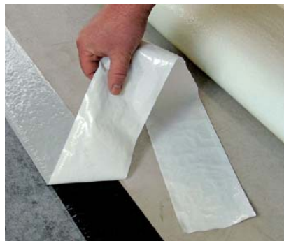
Odstranění fólie z horní strany právě přilepeného pásu.
