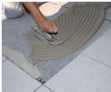
Po provedení izolace pomocí PCI Pecilastic® WS ošetřené pomocí PCI Seccoral® lze ihned pokládat dlažba.
