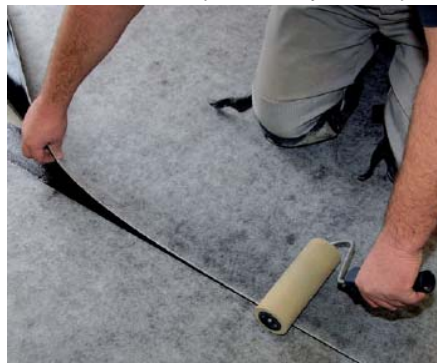
Přichycení a přitlačení PCI Pecilastic® WS pomocí gumového válečku.
