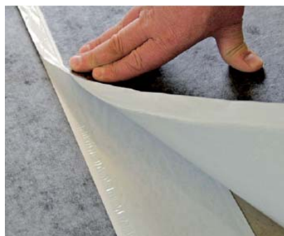
Vyrovnání přesahu. Okraje ochranné fólie musí být zarovnané.
