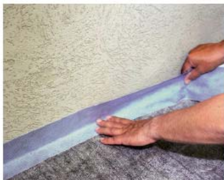
Nalepení samolepicí těsnicí pásky PCI Pecitape® WS.
