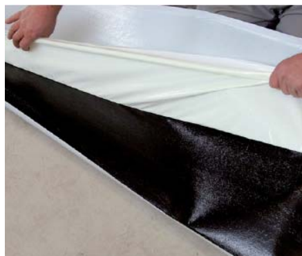
Odstranění fólie ze spodní strany následujícího pásu.
