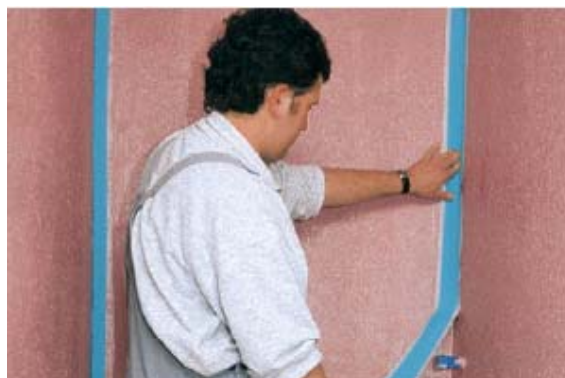
Těsnicí páska PCI Pecitape se vtláčí do čerstvé vrstvy izolačního materiálu a materiálem se okraje přetřou.
