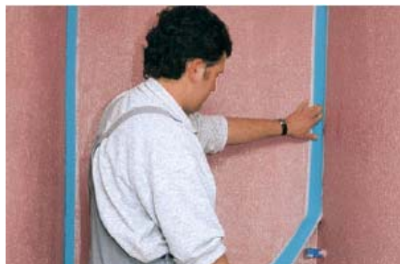
Těsnicí páska PCI Pecitape se vtlačí do čerstvé vrstvy izolačního materiálu a materiálem se okraje přetřou.
