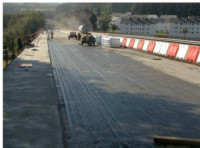
dokonalá příprava povrchu frézováním
