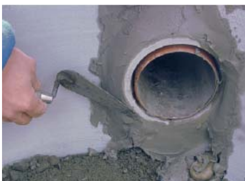
Šachtový vtok opravený s maltou PCI Polyfix ® plus
