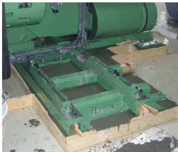
Pomocí zálivky PCI Vergussmörtel je zatížení dokonale přenášeno do podkladu.
