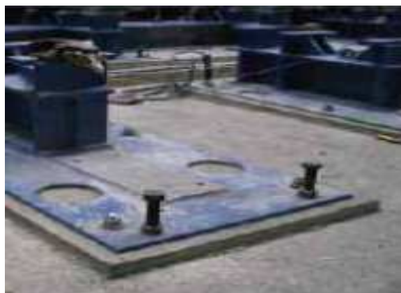
Tekutá zálivka PCI Vergussmörtel dokonale vyplňuje všechny dutiny.
