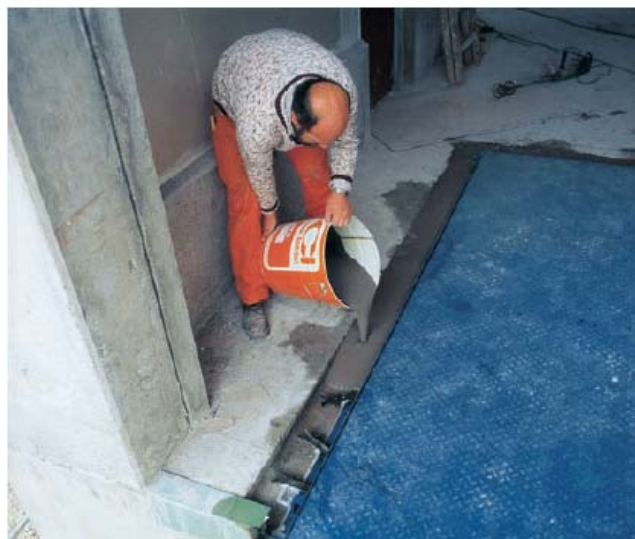
Aplikace zálivky PCI Verguss-Fix na příkladu nakládací rampy
